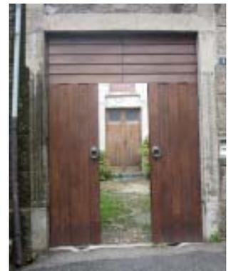
**b** portoni con struttura omogenea: stipiti e architrave in conci di granito
