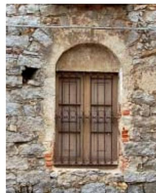
**d** finestra con struttura omogenea: stipiti e arco a tutto sesto in conci di granito
