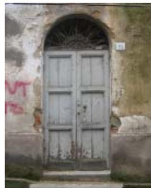
**c** porta con struttura mista: stipiti in bozze o conci di granito e arco in laterizi cotti
