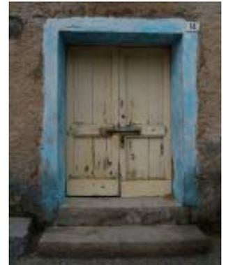
**a** portoni elementari con struttura mista: stipiti in trovanti o bozze di granito e architrave ligneo
