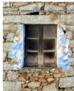
**b** finestra con struttura omogenea: stipiti e architrave in bozze o conci di granito
