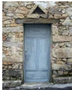
**a** porta elementare con struttura mista: stipiti in trovanti o bozze di granito e architrave ligneo
