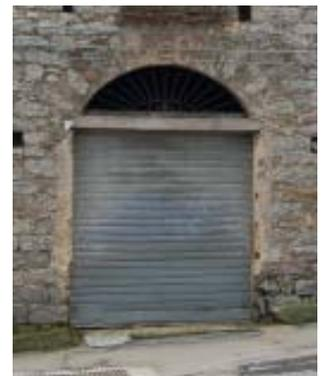
**d** portoni con struttura mista: stipiti in bozze o conci di granito e arco a tutto sesto in conci di granito e laterizi
