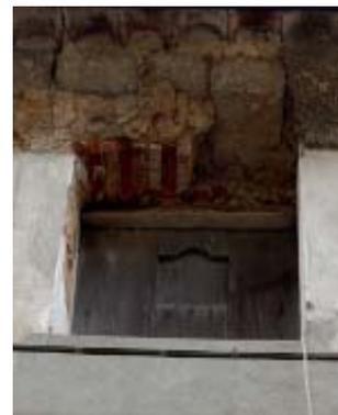
**c** finestra con struttura mista: stipiti in bozze o conci di granito e piattabanda in laterizi cotti
