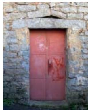
**b** porta con struttura omogenea: stipiti e architrave in bozze o conci di granito
