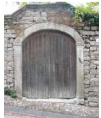
**c** portoni con struttura omogenea: stipiti e arco a sesto ribassato in conci di granito
