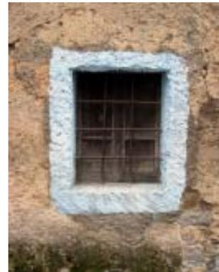
**a** finestra elementare con struttura mista: stipiti in trovanti o bozze di granito e architrave ligneo
